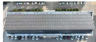
• 沁水新奥光伏车棚
