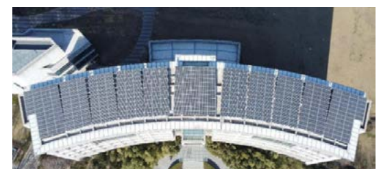
廊坊总部大楼光伏设备改造
