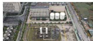
• 余杭新奥分布式光伏发电系统
