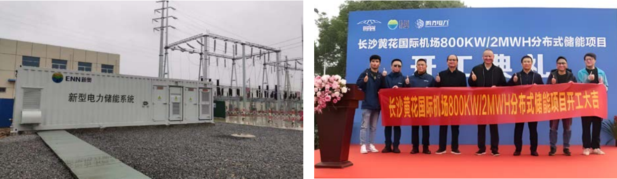
• 安徽宣城增量配电网储能项目 • 黄花国际机场储能项目开工仪式
