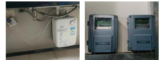
热水宝实时监控器（左）和远程热计量表（右）
