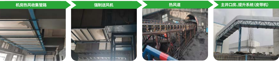
空压机散热风流系统改造工艺示意图
