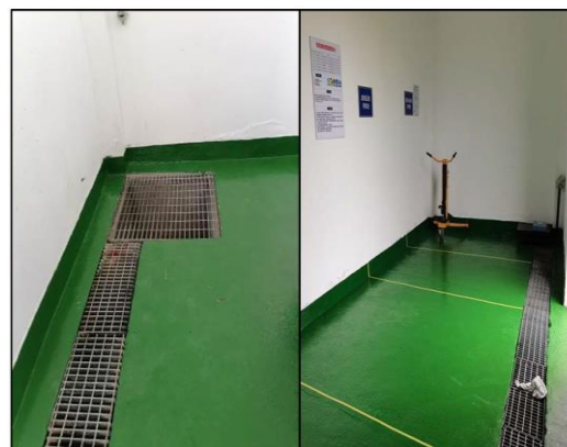
导流沟和废液收集池
